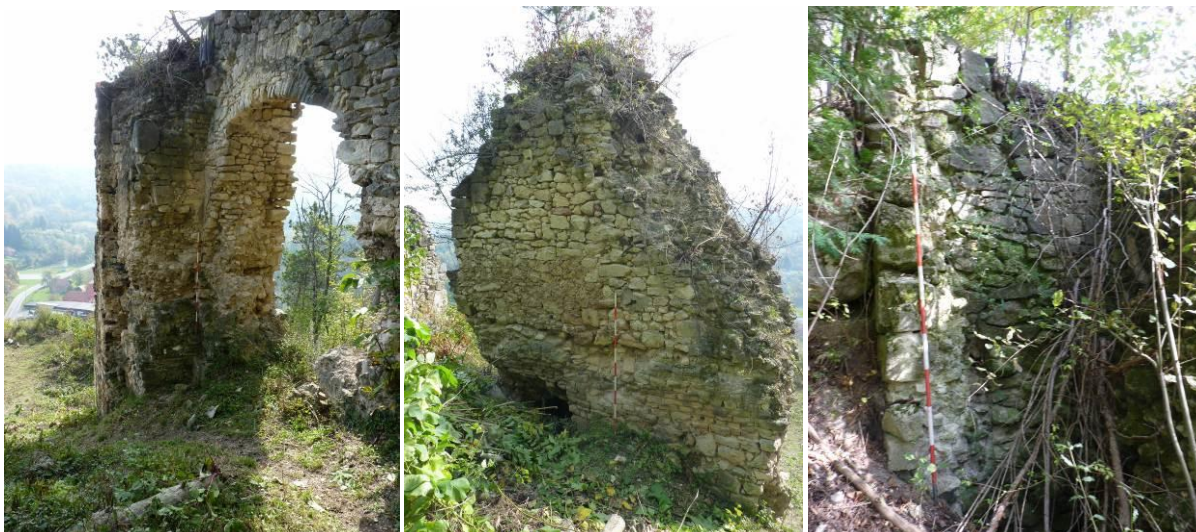
Slika 9, 10 i 11: Elementi središnje kule – lučni otvor, nadvoj i udubina na JZ kutu (fotografirao: Srđan Đuričić)
