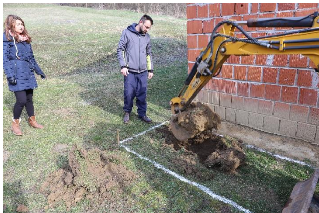
Slika 4: Strojni iskop uz nadzor arheologa
