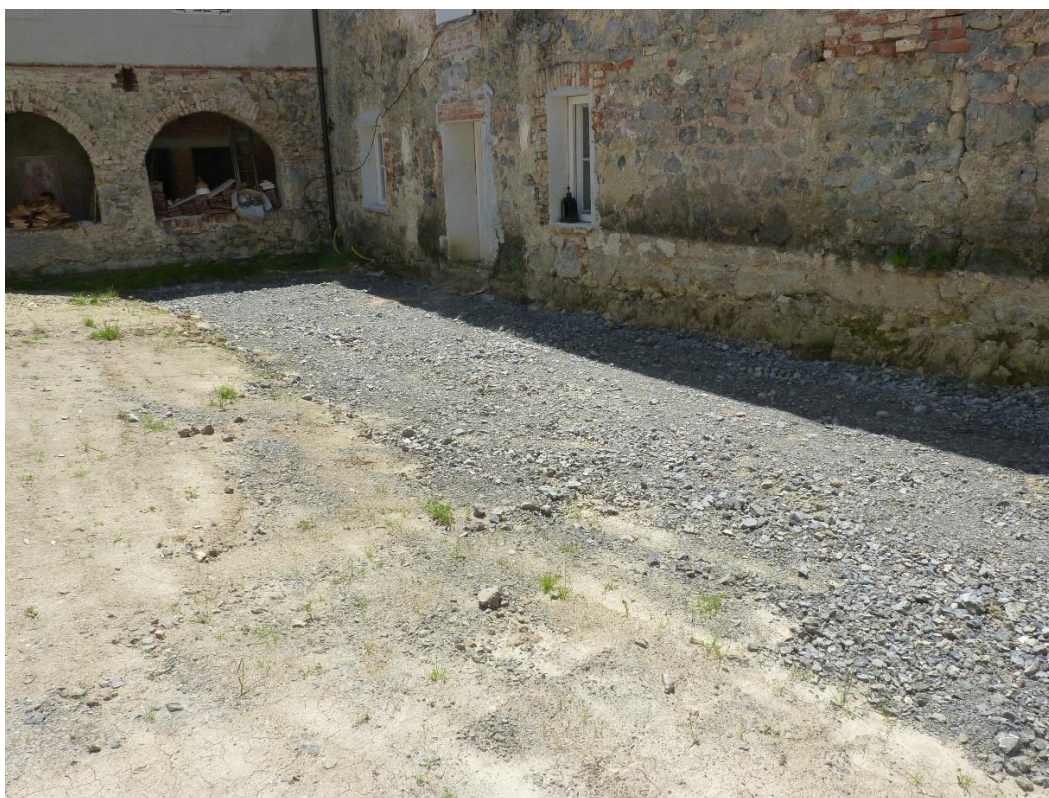
Slika 3: Fotografija zapadno dijela dvorišta manastirskog kompleksa sa uklonjenim slojevima (foto: S. Đuričić)
