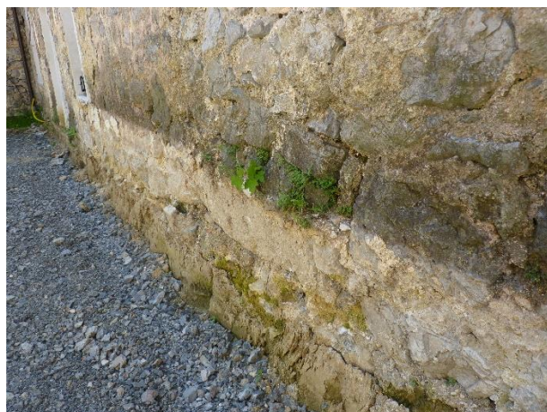
Slika 10 i 11: Diskoloracija kamena na zapadnom krilu
